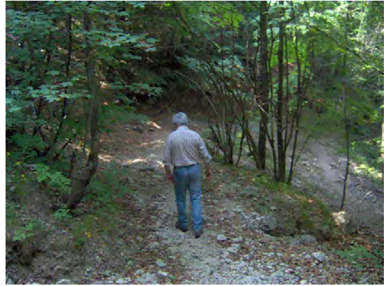
Strada con carreggiata ormai non più transitabile
