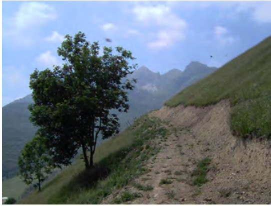
Realizzazione di strada di IV classe priva di inerbimenti sulla scarpata di monte
