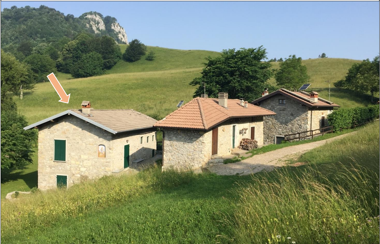
Contesto di inserimento dell'edificio oggetto di intervento (a sinistra)
