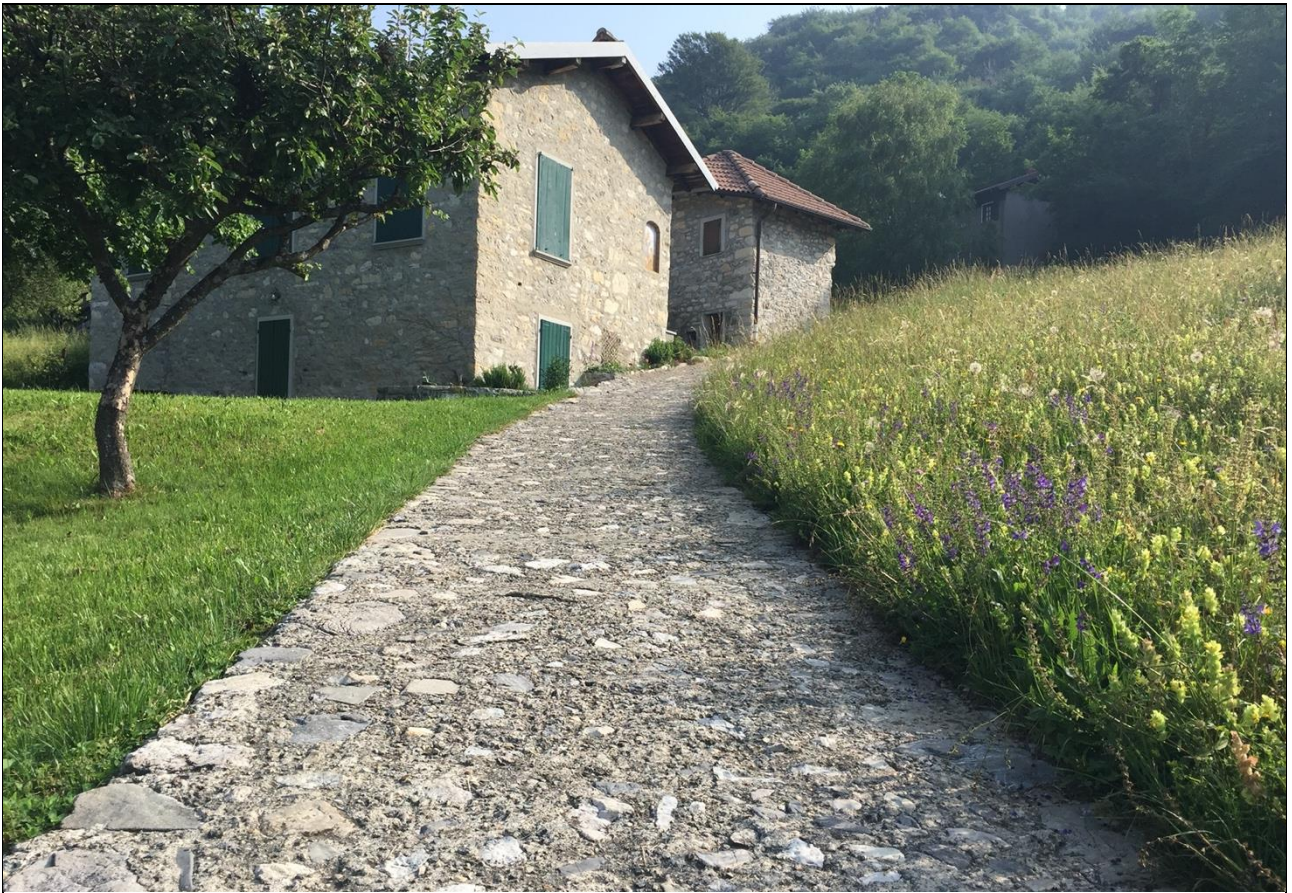
Dettaglio dalla strada dell'edificio oggetto di intervento
